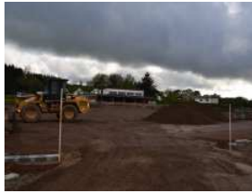
Es bedarf noch vieler Vorarbeiten, bis die Spezialfirma den Kunstrasen anlegt. Am 1. September soll die neue Anlage eingeweiht werden. (Fotos: Pesch)
